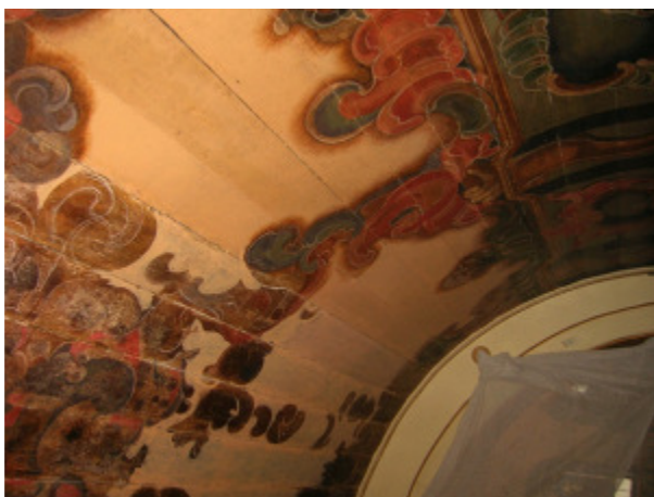
Figura 3: Detalhe da pintura do forro da capela-mor da Ig. de Santo Antônio, São Paulo/SP, durante restauro. Foto: Júlio Moraes, 2006.
