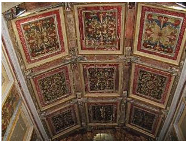
Figura 2: Forro da capela-mor da Ig. de N. Sra. do Rosário, Embu/SP. Foto: Myriam Salomão, 2012.
