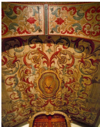
Figura 1: Detalhe do forro da capela-mor da Capela do Sítio Santo Antônio, São Roque/SP. Foto: Percival Tirapeli, 2003.
